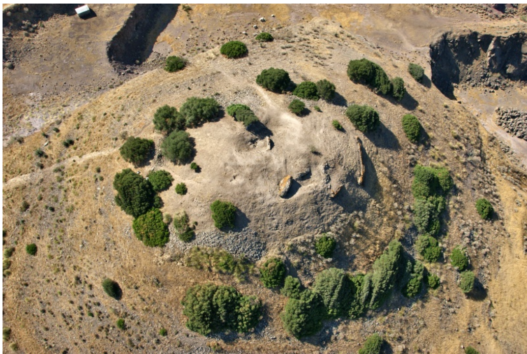
BARATULI – MONASTIR (CA). Foto aerea a bassa quota dei ruderi nel luglio 2011 all'inizio dei lavori (foto G. Alvito Teravista).
