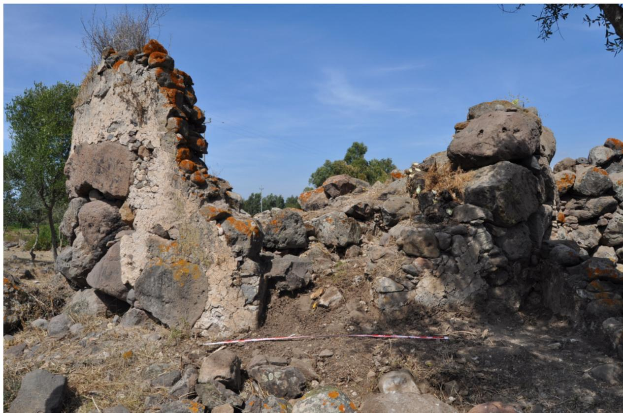
Figura 13. Torre 2. Apertura della porta e rivestimento di calce, entrambi di epoca contemporanea (foto dell'autore O.R.G.).
