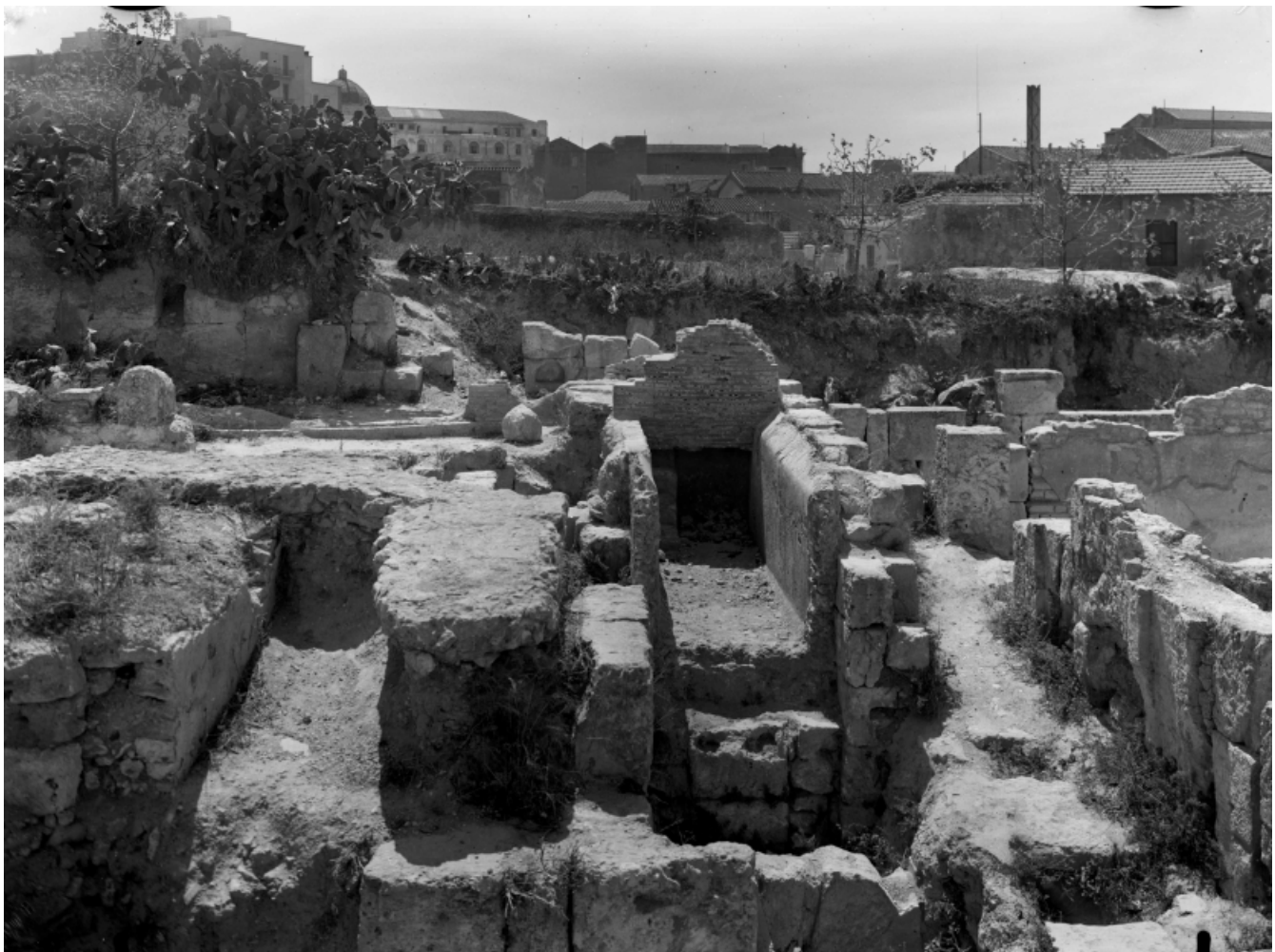
Figg. 25-26. CAGLIARI - VILLA DI TIGELLIO. Scavi del 1939. Veduta d'insieme da ovest (così è riportato nella scheda dello scatto) della parte posteriore della Casa degli Stucchi (Archivio fotografico Soprintendenza AFCA 2426 e 2261)
