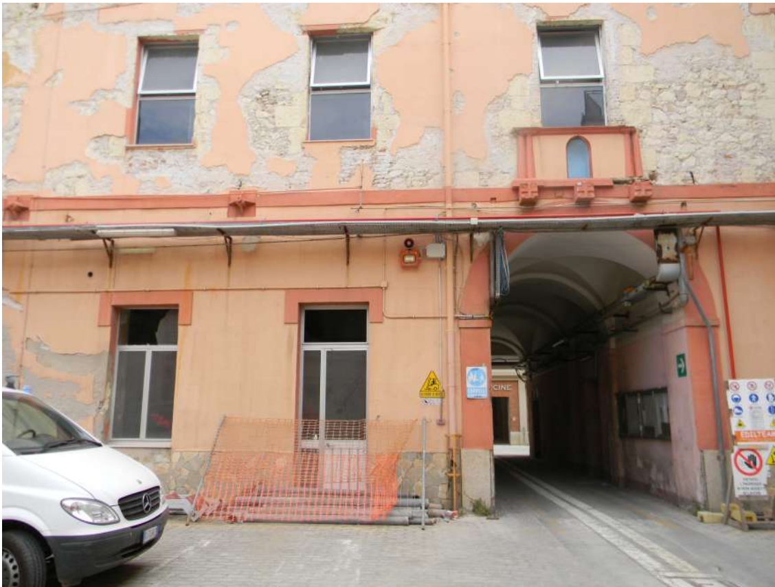
Fig. 3 - CAGLIARI - Ex Manifattura Tabacchi. Particolare della facciata Est dell'Edificio B (foto C. Nieddu)
