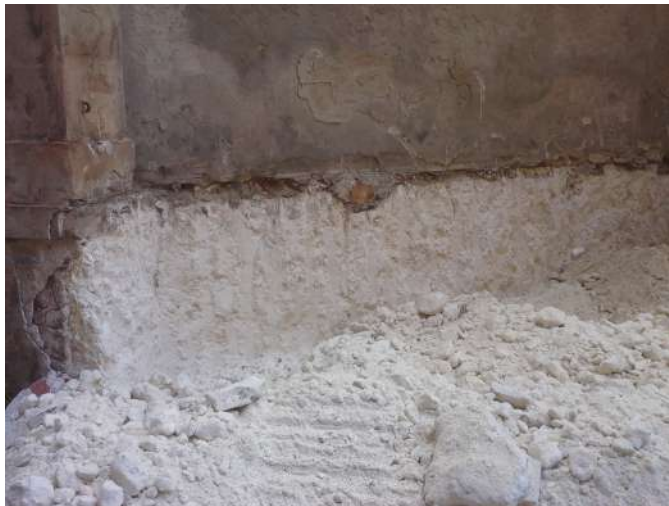
Figg. 18.1 e 18.2 - CAGLIARI - Ex Manifattura Tabacchi. Area uscita di sicurezza, lato Viale Regina Margherita: scavo per la posa in opera dei cavidotti (foto C. Nieddu)
