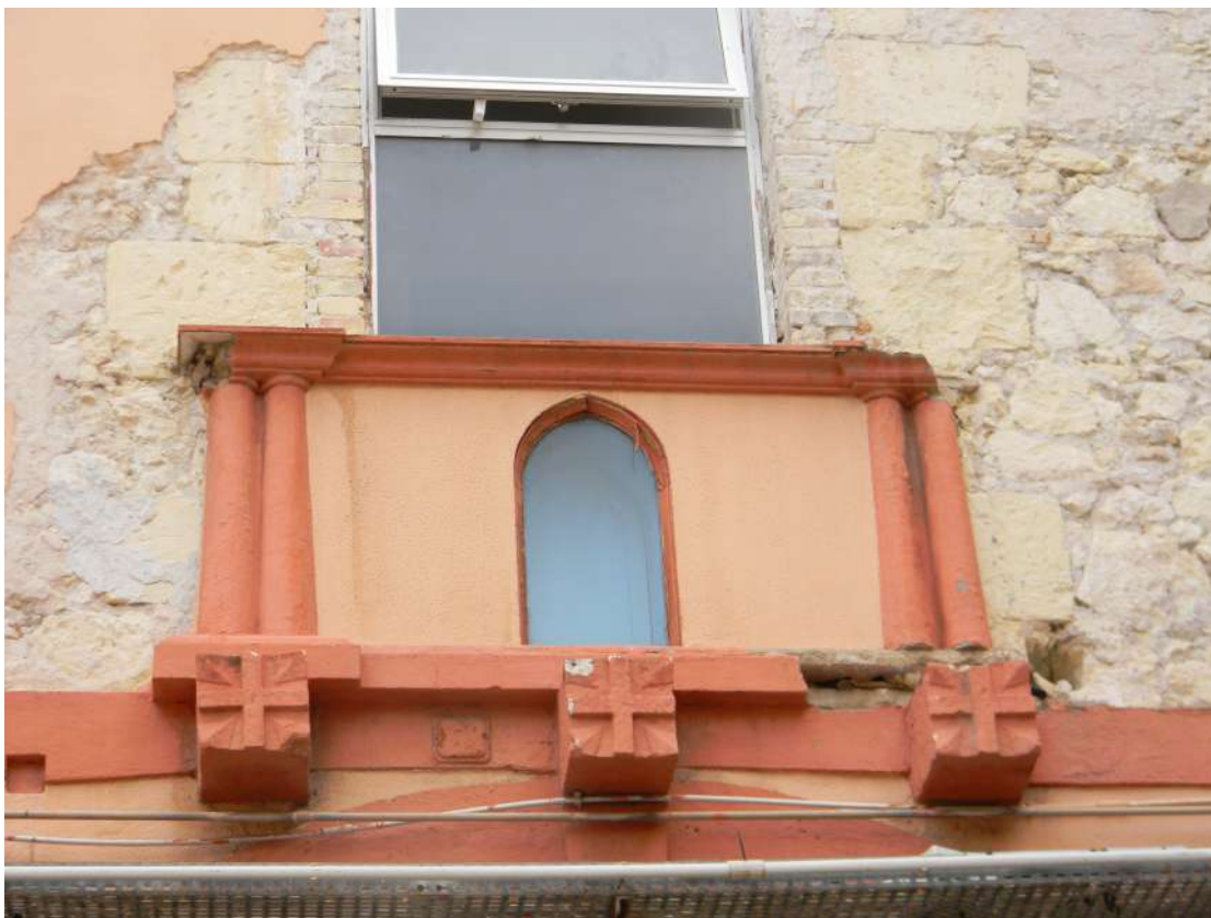
Fig. 4 - CAGLIARI - Ex Manifattura Tabacchi. Particolare della facciata Est dell'Edificio B (foto C. Nieddu)
